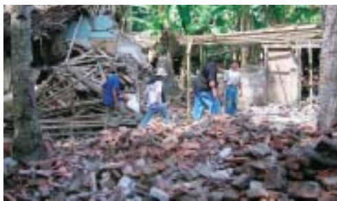
復興作業は現在も続く(ジャワ島)
